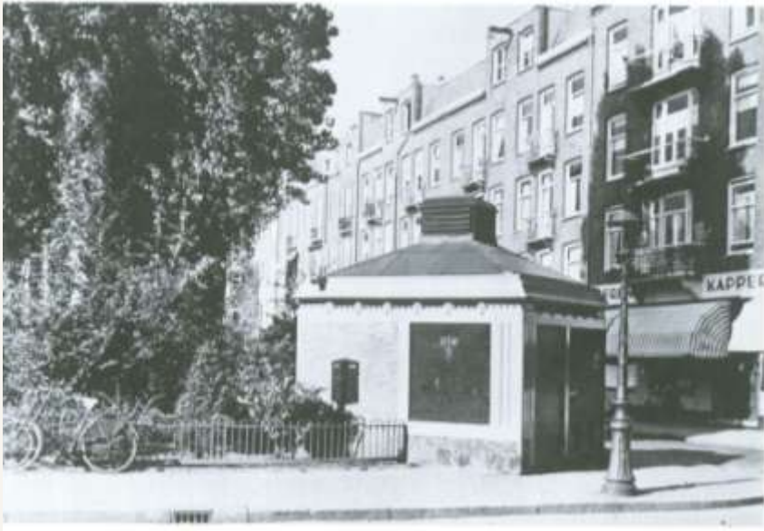
A.A. Kok. Een van de vijf basistypen transformator- huisjes (1919)
