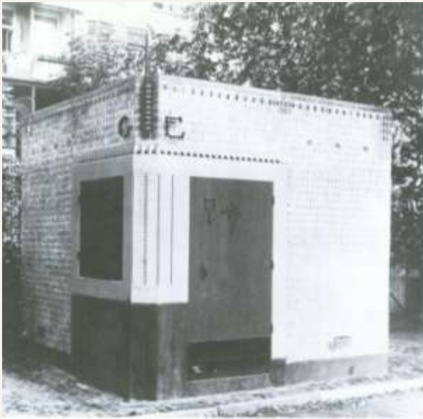
A.A. Kok. Een van de vijf basistypen transformator- huisjes (1919)
